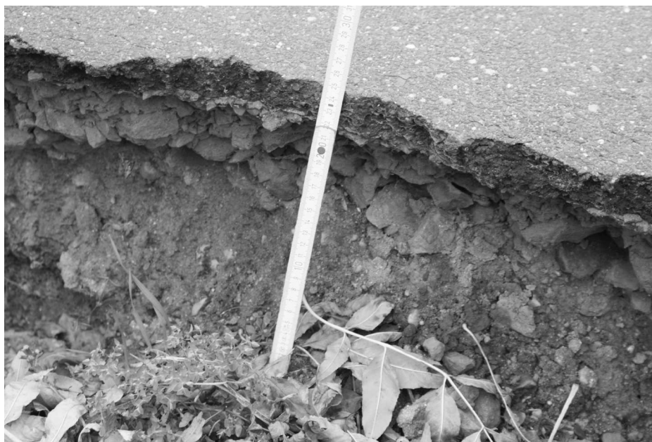
Fot. 5 Szczegół odsłoniętej konstrukcji nawierzchni drogi gminnej
