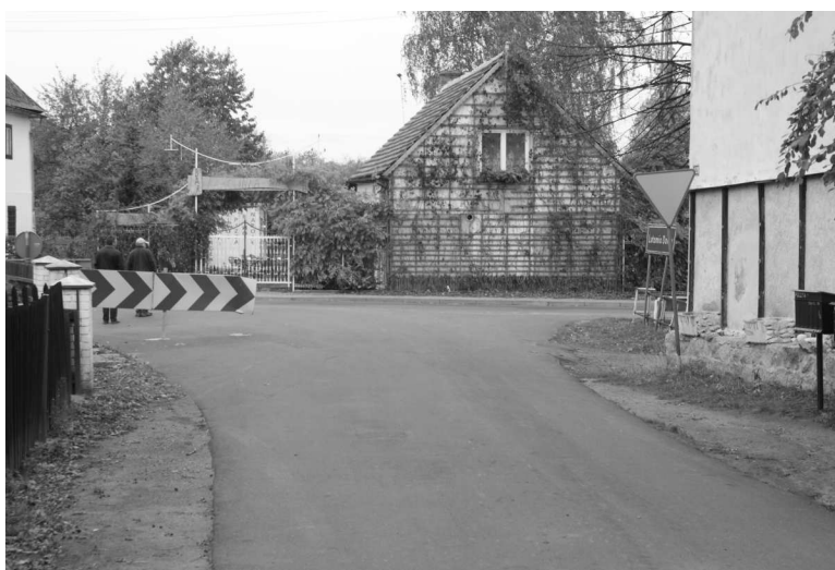
Fot. 3 Widok ogólny drogi gminnej w rejonie skrzyżowania z drogą powiatową (z prawej strony widoczne włączenie drogi gminnej (działka nr 728) jeszcze o nawierzchni gruntowej)
