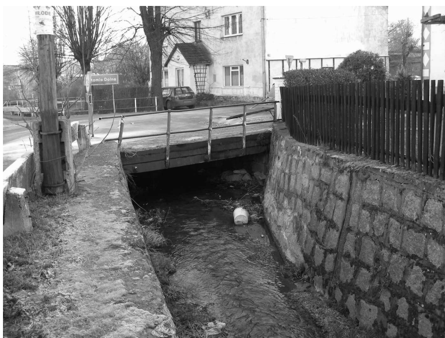
Fot. 1 Widok ogólny mostu od WG– stan istniejący (styczeń 2008r.)
