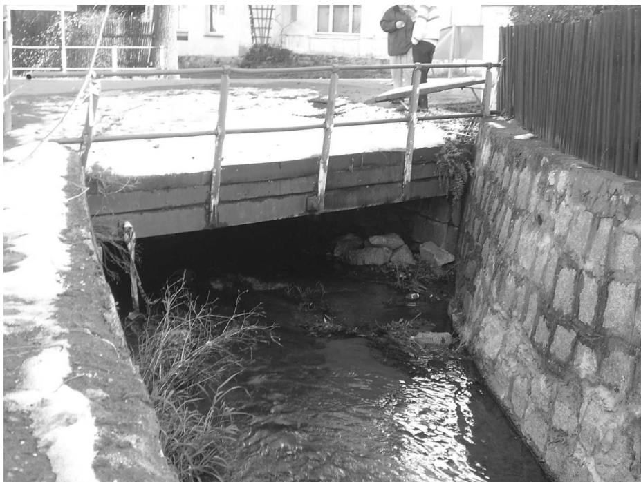
Fot. 8 Widok mostu istniejącego od strony WG
