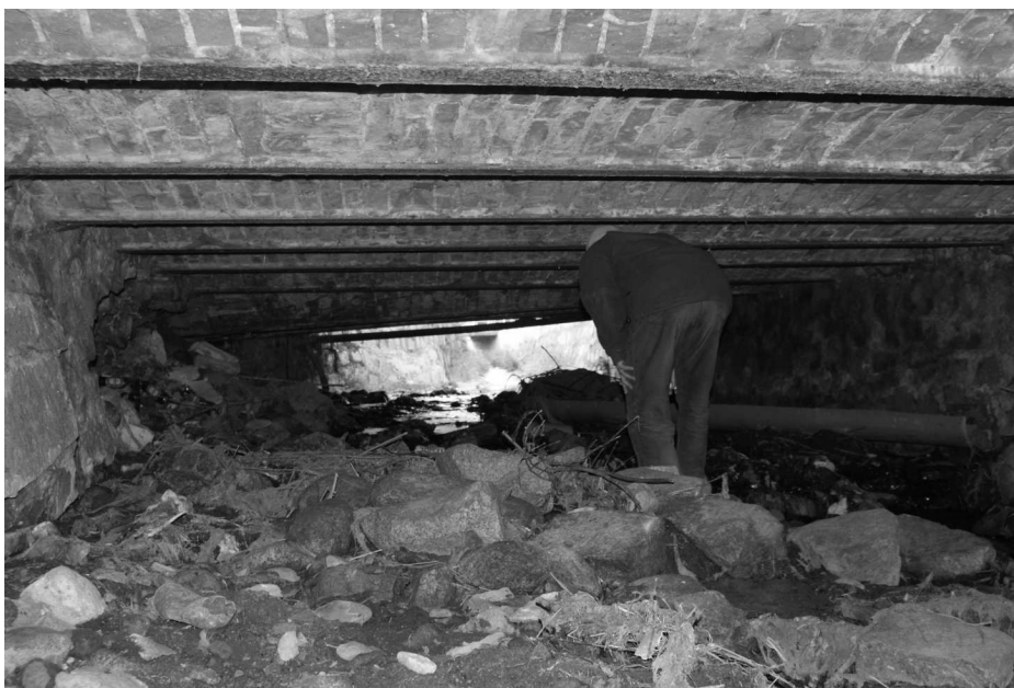
Fot. 10 Konstrukcja mostu istniejącego od spodu
