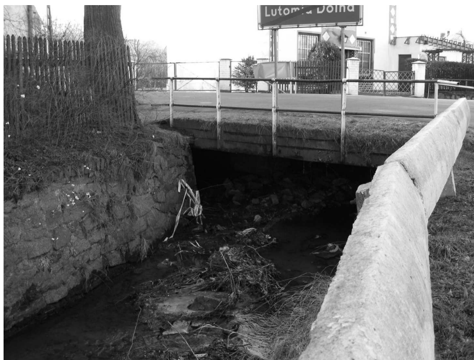
Fot. 9 Widok mostu istniejącego od strony WD
