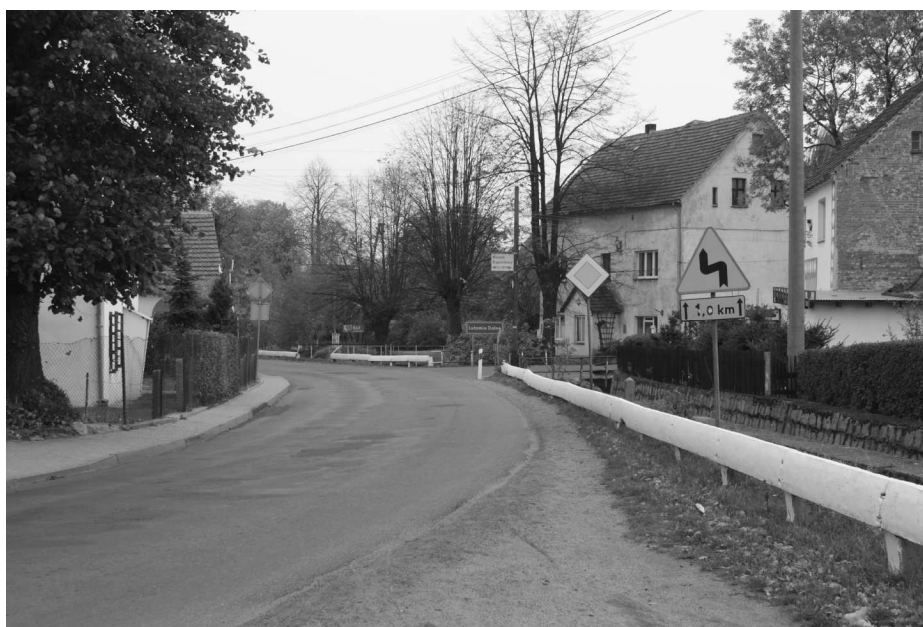
Fot. 2 Widok ogólny drogi powiatowej w rejonie skrzyżowania z drogą gminną
