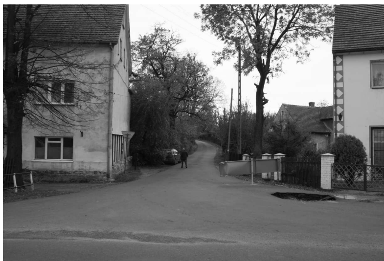
Fot. 4 Droga gminnej w rejonie skrzyżowania z drogą powiatową z widocznym zapadnięciem nawierzchni jezdni na moście (z prawej strony widoczne włączenie drogi gminnej (działka nr 728) jeszcze bez zabudowy kostką betonową)
