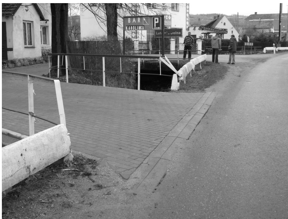
Fot. 7 Szczegół włączenia nowej nawierzchni na kładce do drogi powiatowej
