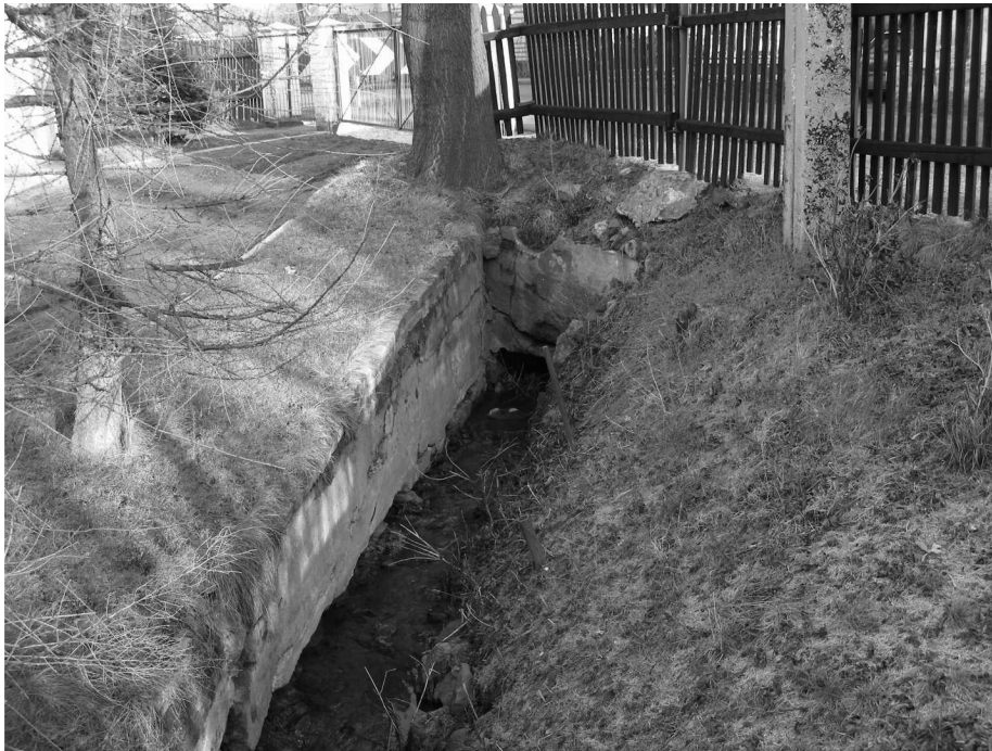
Fot. 14 Wlot rowu melioracyjnego do konstrukcji przepustu
