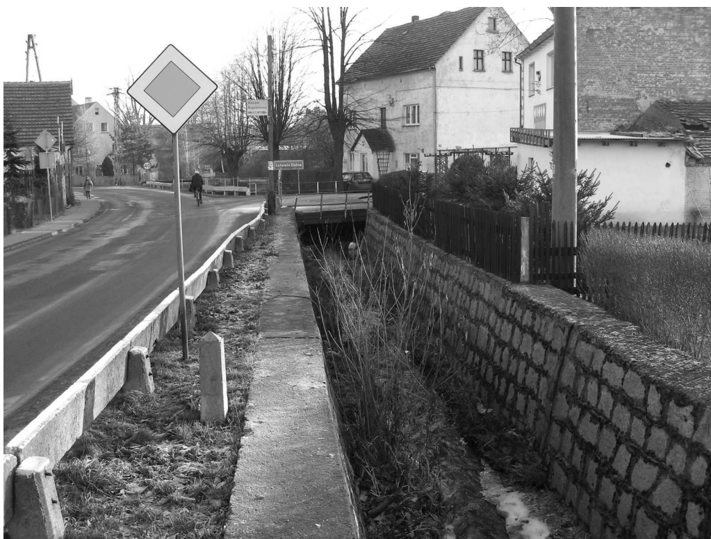
Fot. 17 Konstrukcja obudowy potoku Bielina od strony WG
