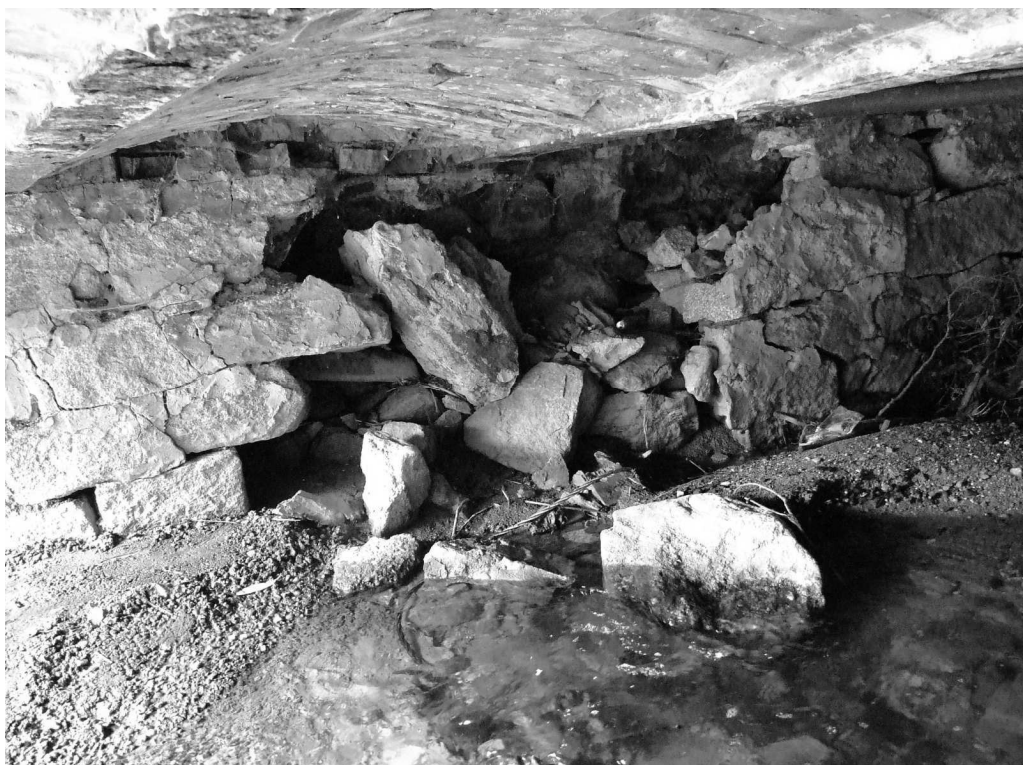
Fot. 13 Szczegół oparcia na kamiennym murze oporowym koryta potoku Bielina – widoczne znaczne ubytki i zapadnięcie konstrukcji ściany oporowej
