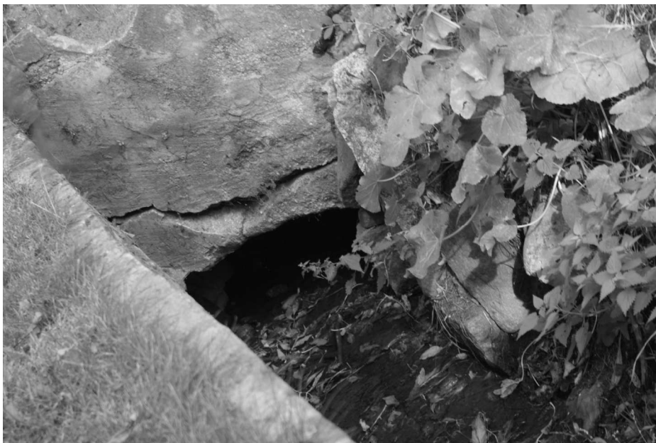
Fot. 15 Szczegół wlotu rowu melioracyjnego do konstrukcji przepustu
