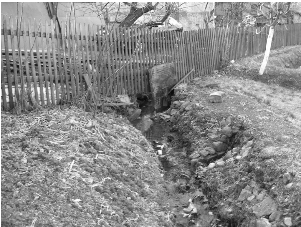
Fot. 21 Widok rowu melioracyjnego powyżej wlotu do przepustu (widoczne ogrodzenie rozgraniczające przyległe posesje)
