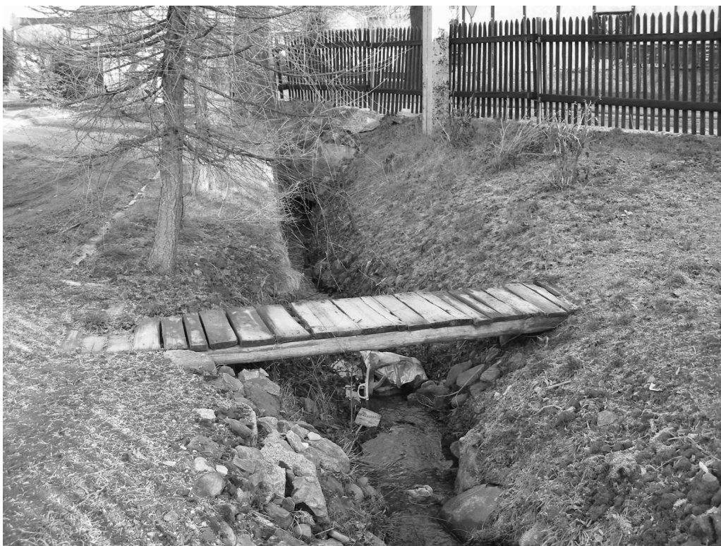
Fot. 20 Widok rowu melioracyjnego na odcinku bezpośrednio przed wlotem do przepustu
