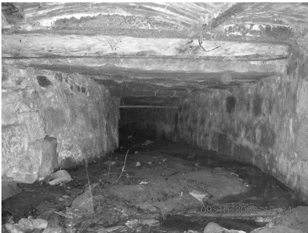
Fot. 16 Wlot konstrukcji obudowy rowu melioracyjnego do potoku Bielina
