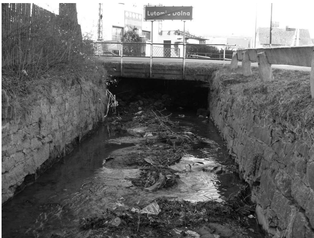
Fot. 18 Konstrukcja obudowy potoku Bielina od strony WD
