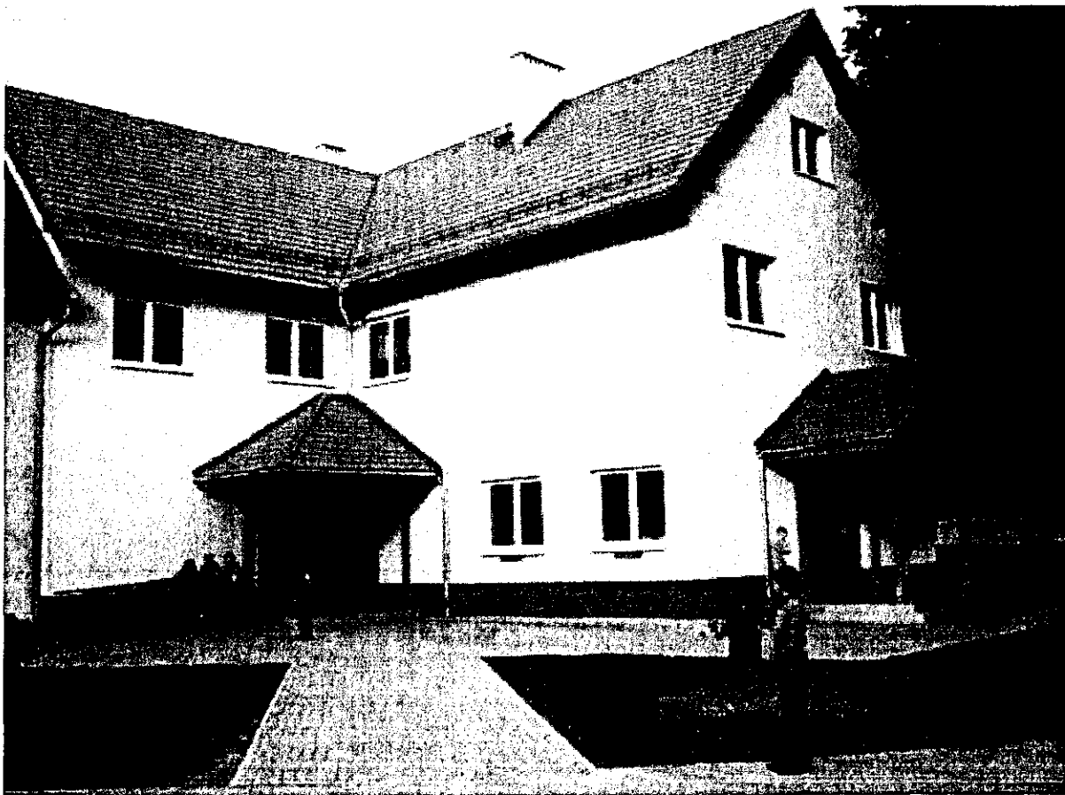
Fot 1. Budynek Szkoły Podstawowej w Bystrzycy Górnej.
