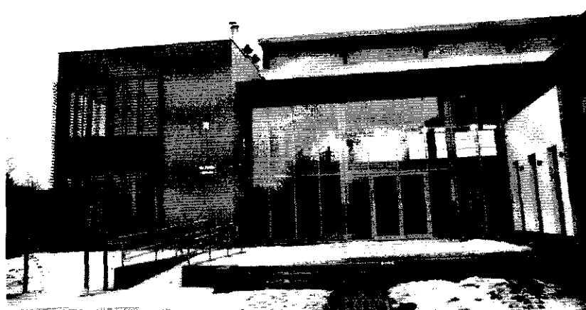
Hala sportowa w Witoszowie Dolnym (wejście główne)
