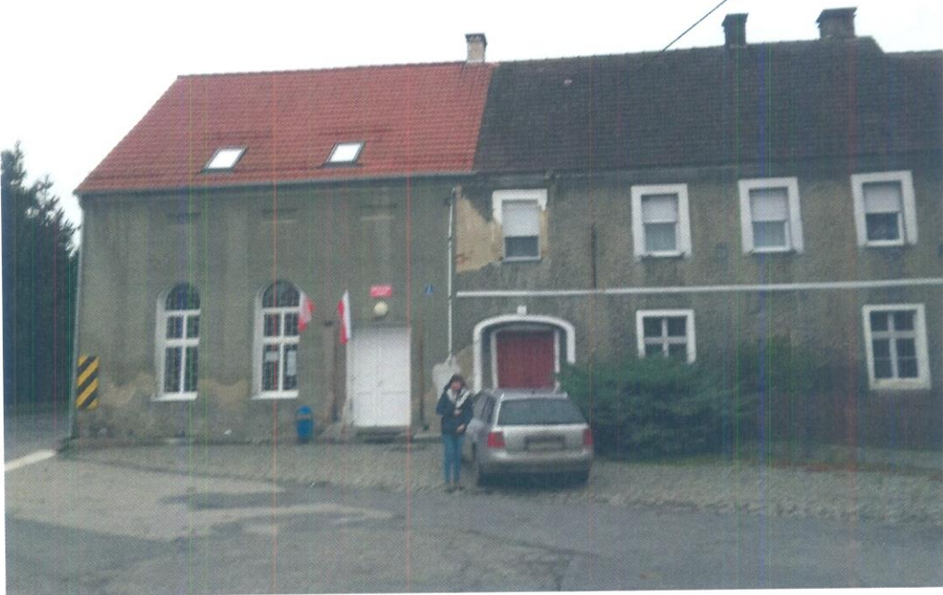
Świetlica wiejska w centrum wsi
