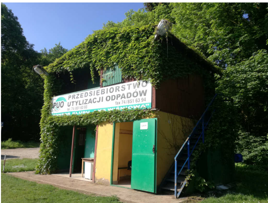
Istniejący budynek szatni przeznaczony do przebudowy i remontu.
