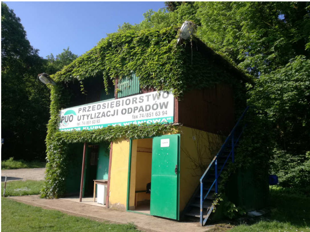
Istniejący budynek szatni przeznaczony do przebudowy i remontu.
