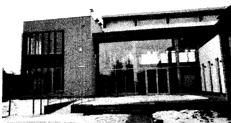
Hala sportowa w Witoszowie Dolnym (wejście główne)
